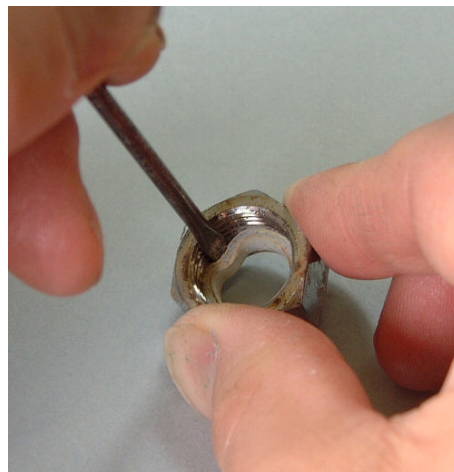
古いテフロンパッキンの 取り外し
